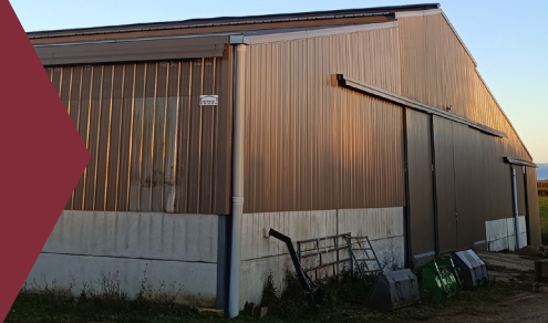
Vue sur la façade, porte de curage de l'aire paillée, tôles perforées + translucides, décalage de toiture
